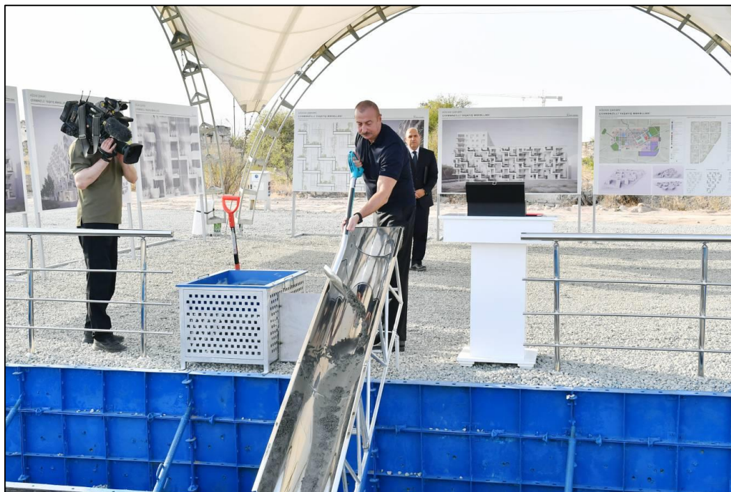
Məcburi köçkünlər üçün Ağdam şəhərində inşa olunacaq yaşayış məhəlləsinin təməlinin qoyulması. 04.10.2022
