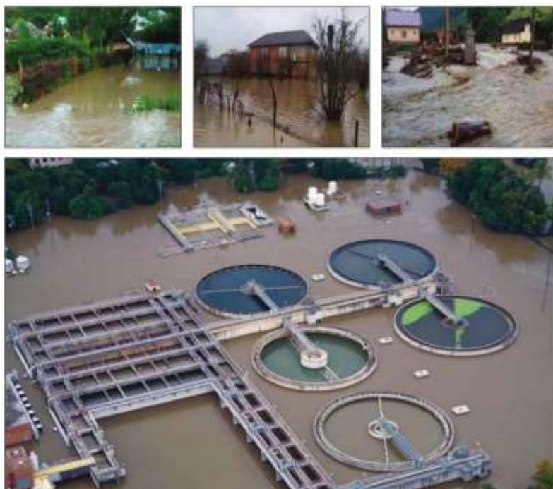
Səkil 1. Sel və daşqınlardan sonra yaşayış məntəqələrinin və tullantı su təmizləyici qurğuların vəziyyəti.
