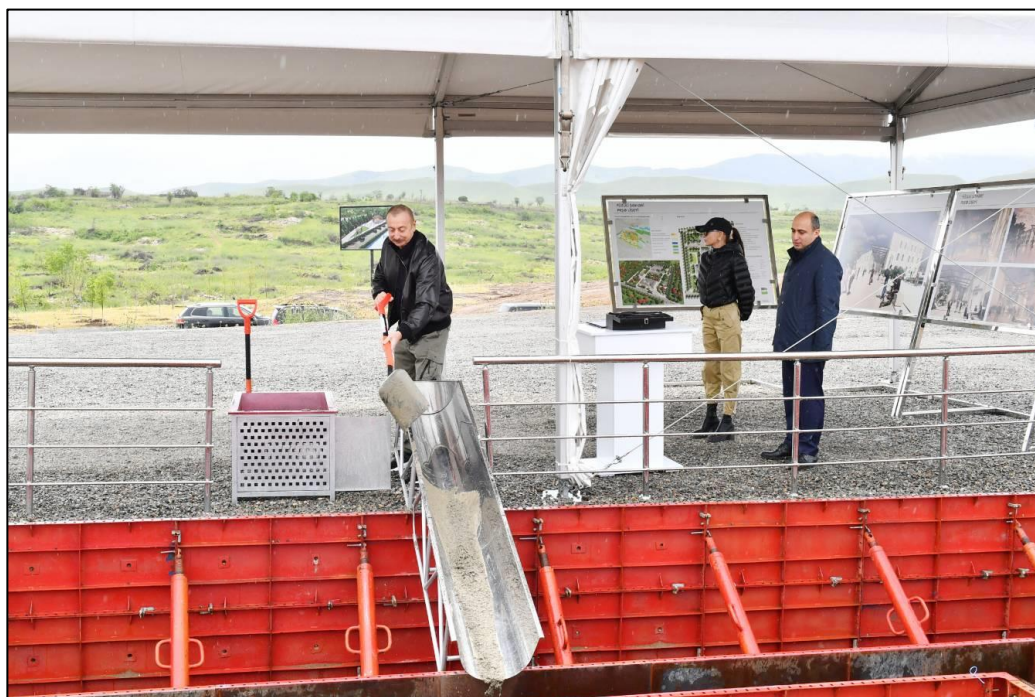
Füzuli şəhərində inşa olunacaq Peşə Liseyinin təməlinin qoyulması mərasimi. 10.05.2022
