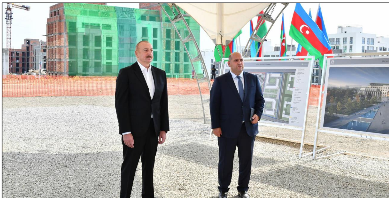
Füzuli şəhərində inzibati binanın təməlinin qoyulması. 16.10.2023
