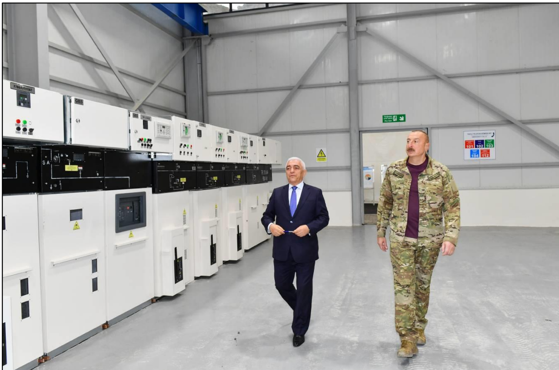
“Çıraq-1” Kiçik Su Elektrik Stansiyasında tikinti işlərinin gedişi ilə tanışlıq. 27.06.2022
