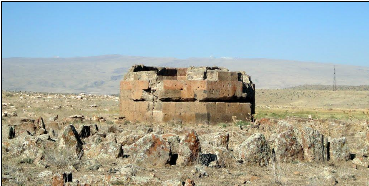
Разрушенный мавзолей в селе Галыш (Аруч) Аштаракского района.
