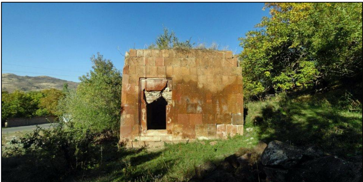
Разрушенный мавзолей в селе Такия (Базмахпюр) Аштаракского района.
