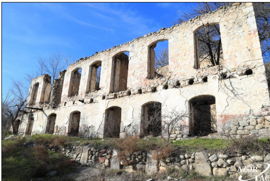
Mincivan qəsəbəsində erməni vandalları tərəfindən dağıdılmış memarlıq binası
