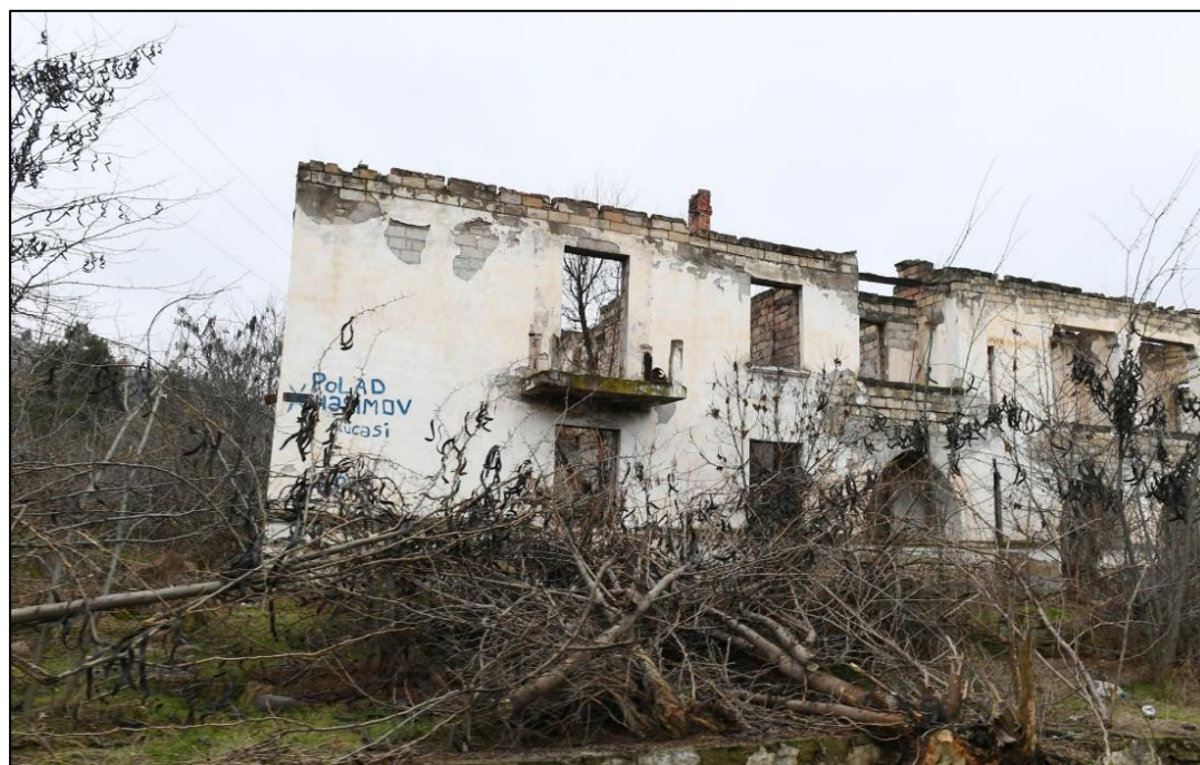
Zəngilanda erməni vandalları tərəfindən dağıdılmış bina
