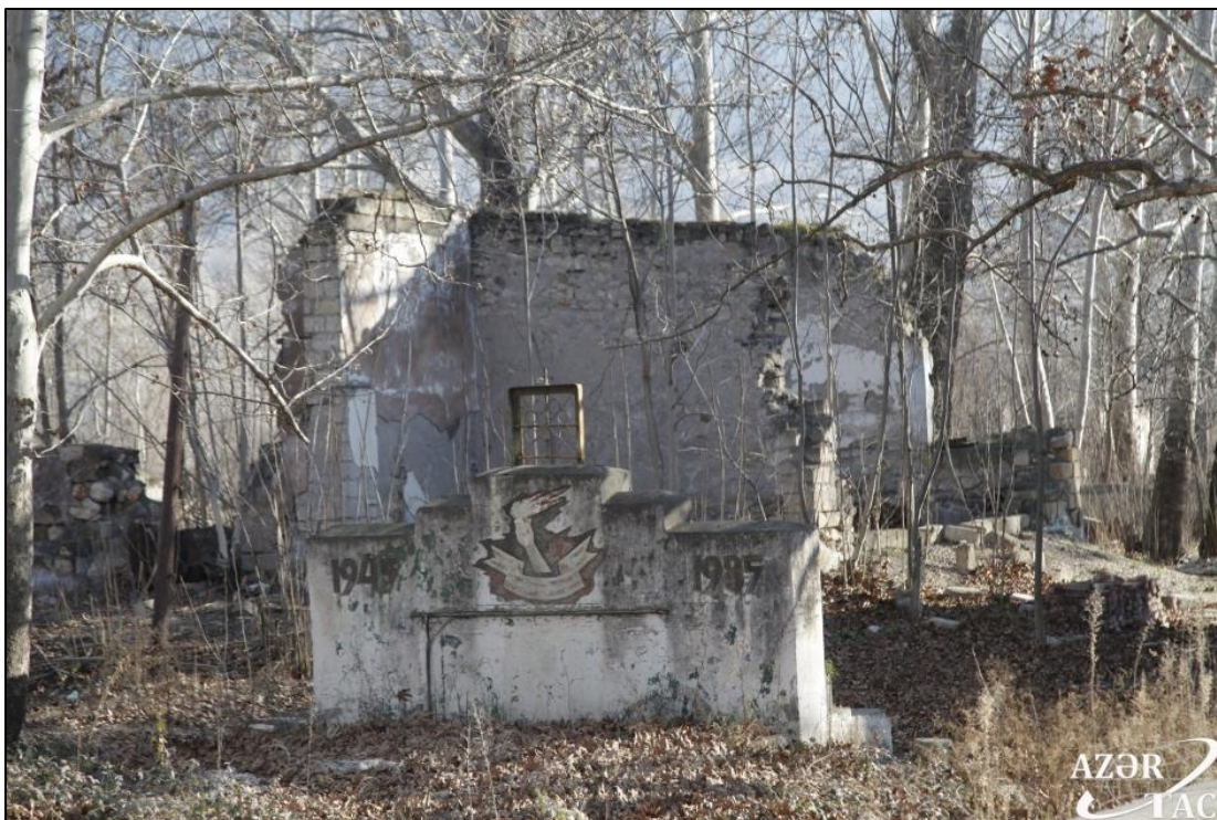
Mincivan qəsəbəsində erməni vandalları tərəfindən dağıdılmış abidə
